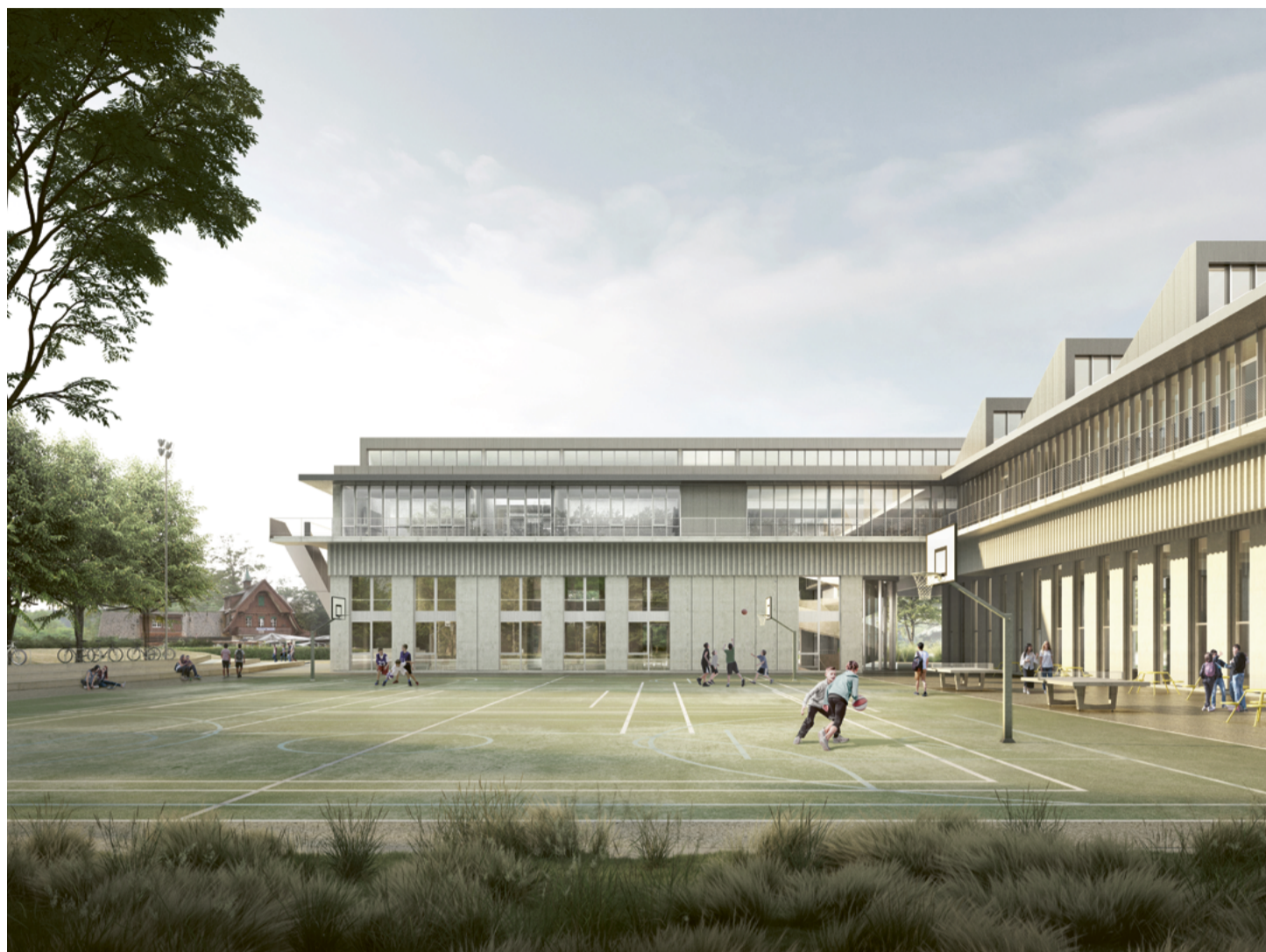
Das neue Schulhaus für zwölf zusätzliche Sekundarklassen entsteht in einer parkähnlichen Umgebung im Herzen von Sursee direkt an der Sure.
